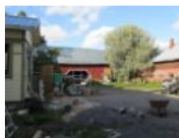
Kuva 219. Konesuoja ja navetta (Q13)
