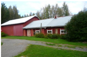
Kuva 21. Vanha navetta ja varasto (B4).
