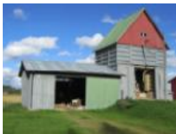
Kuva 224. Kuivaaja ja konesuoja (R7).
