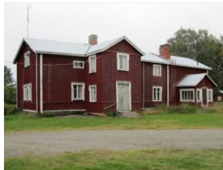
Kuva 271. Hietalahden talo v. 2012.
