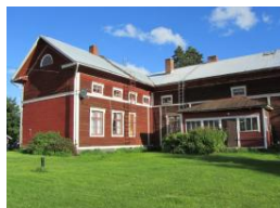
Kuva 233. Päärakennuksen (R1) läntinen julkisivu.
