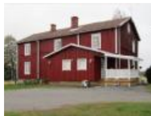
Kuva 143. Muurimäentalon eteläinen ulkisivu.
