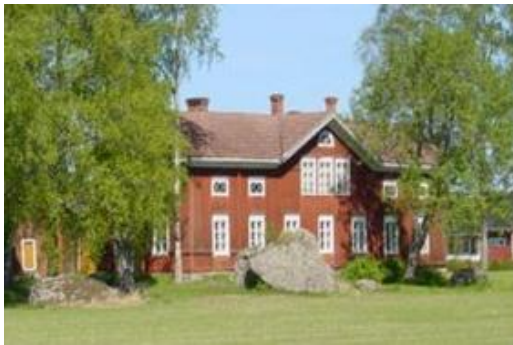
Kuva 120. Auralan talo v. 2002. Itäinen julkisivunäkymä kirkonkylälle.
