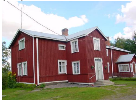
Kuva 270. Hietalahden talo v. 2002.
