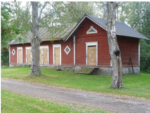
Kuva 7. Makasiinirakennus vuodelta 1881-1883 (A12).
