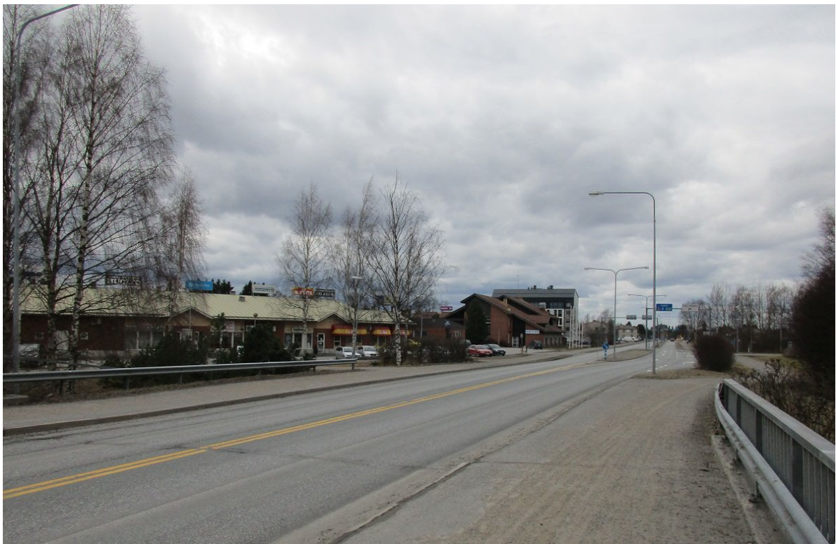
Kuva 2. Kuva suunnittelualueelta valtatie 3 (Tampereentie) varresta Alkiontien alikulkusillalta Vaasan suuntaan
