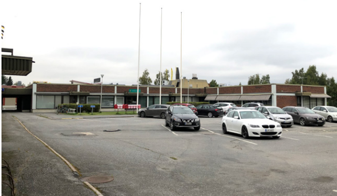
Kuva 12. Kunnan virastotalon sisäpihaa tontinrajalta kuvattuna (Ramboll 09/2023).
