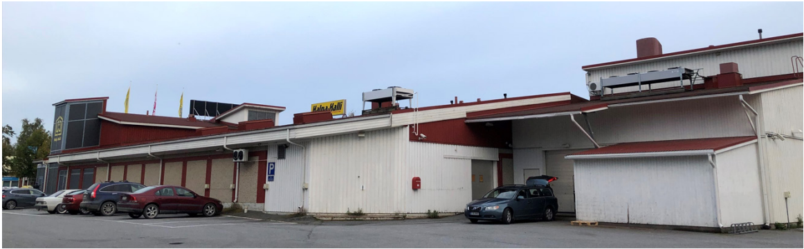
Kuva 16. Halpa-Hallin lounaissivu (Ramboll 09/2023).
