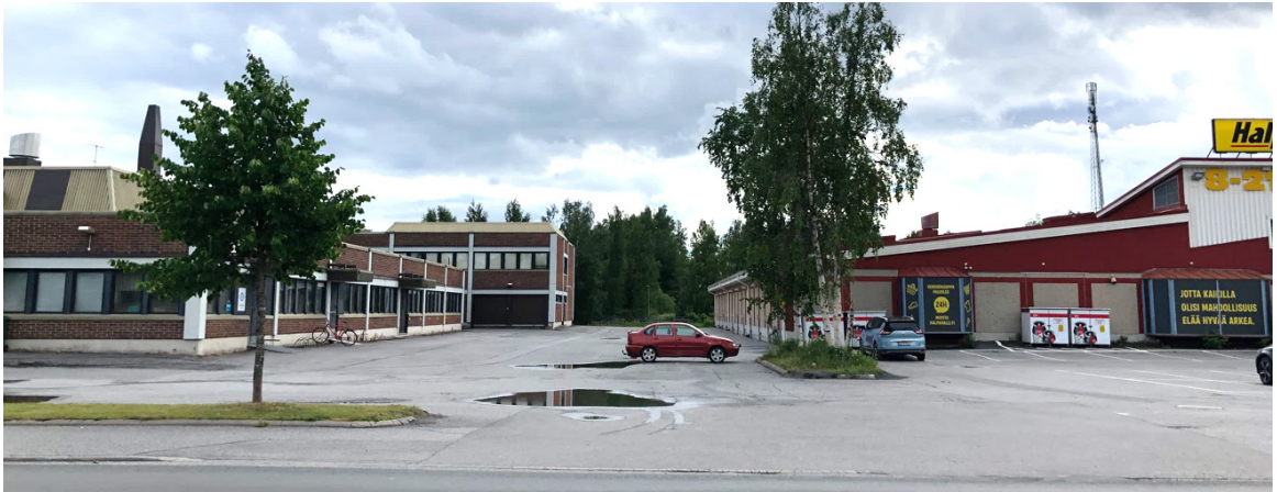
Kuva 9. Kunnan virastotalo vasemmalla ja Halpa-Halli oikealla sekä niiden välinen pysäköintialue (Ramboll 07/2022).
