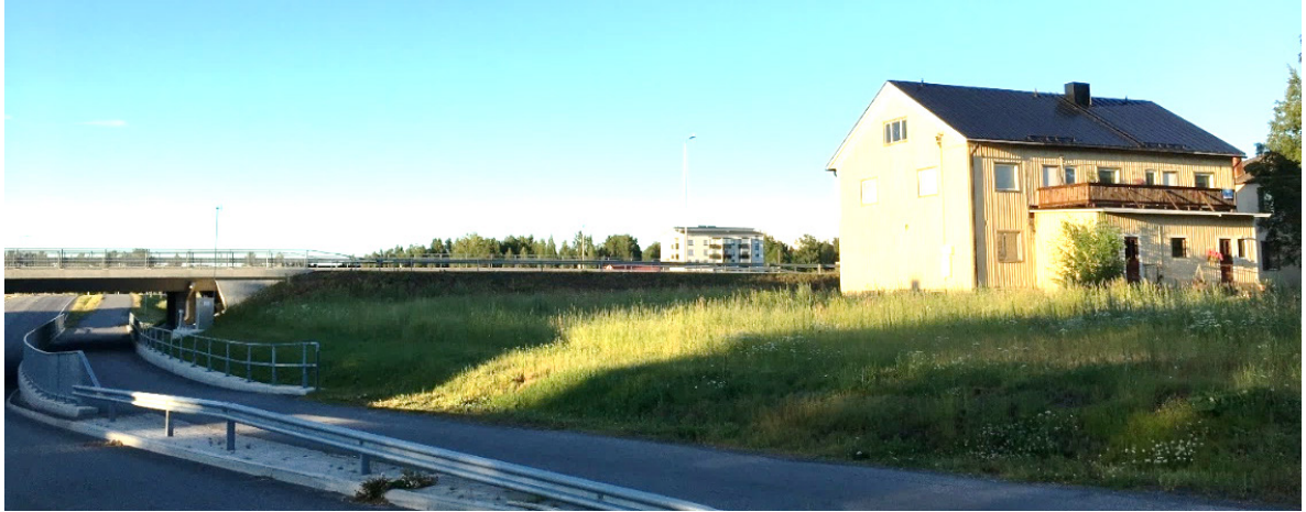
Kuva 8. Ratikyläntien alikulku ja pyörätie sekä korttelin 51 tontilla 8 sijaitseva rakennus (Ramboll 07/2022).
