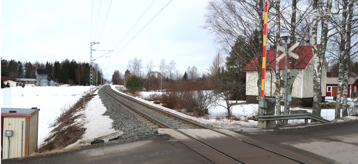
Kuva 7. Kuva Alhontien tasoristeyksestä länteen (Ramboll 2024). Oikealla Alhontie 10 pihapiiri.
