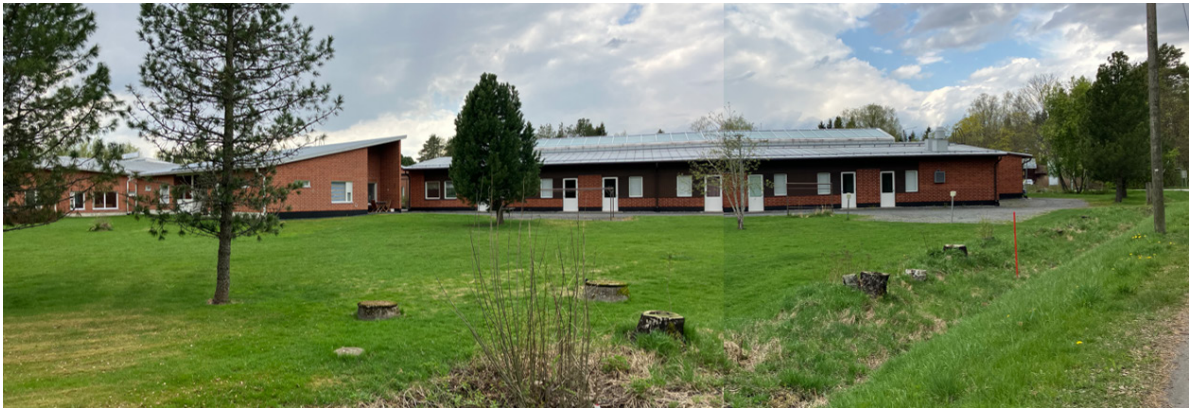
Kuva 13. Länsitien suunnasta alueen rakennuskantaa (Ramboll Finland Oy 05/2026).
